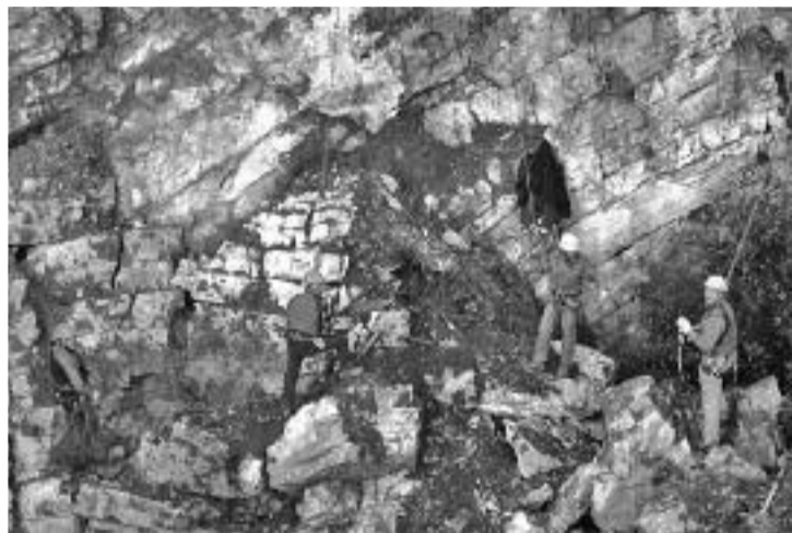
Operai all'opera lungo le pareti del monte Comer
