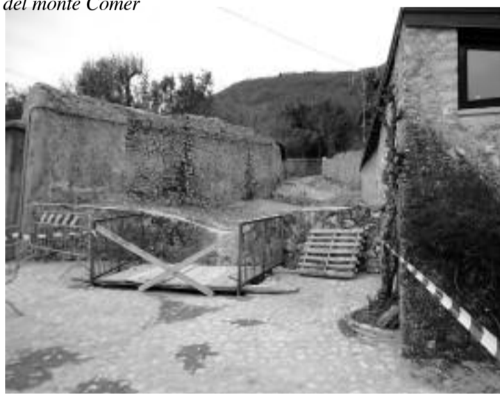
I lavori di risanamento del rio Guandalini
